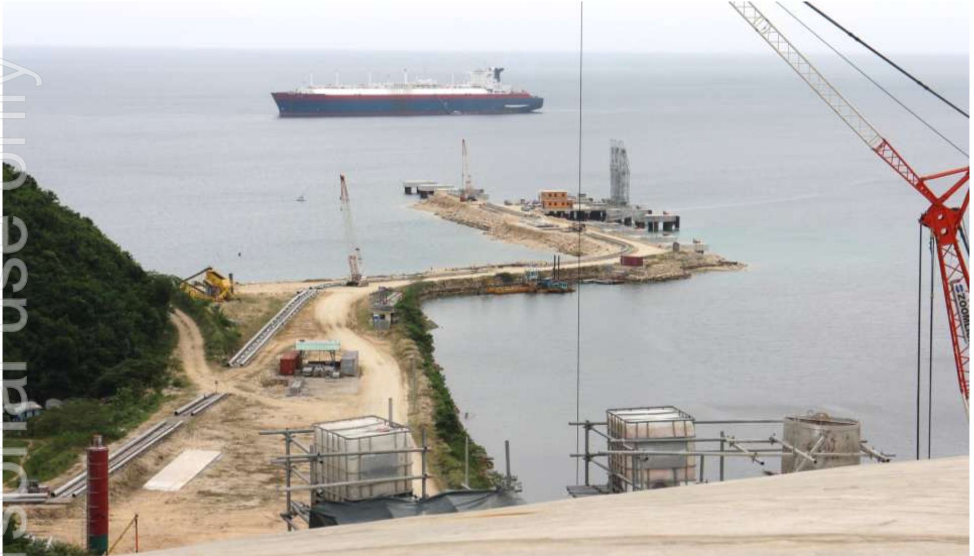
LNG Ship approaching Pagbilao from the top of the LNG Tank
