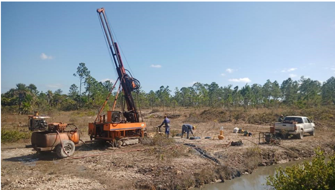
Drilling - El Pilar
