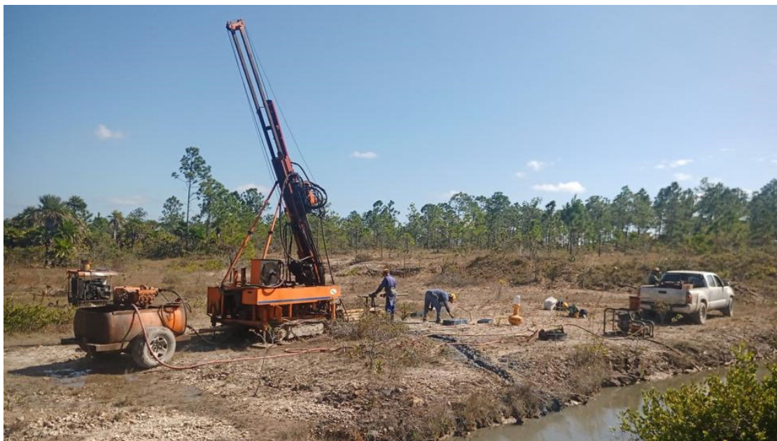
Drilling - El Pilar
