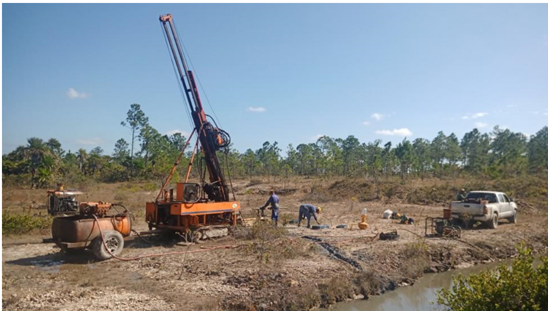
Drilling - El Pilar
