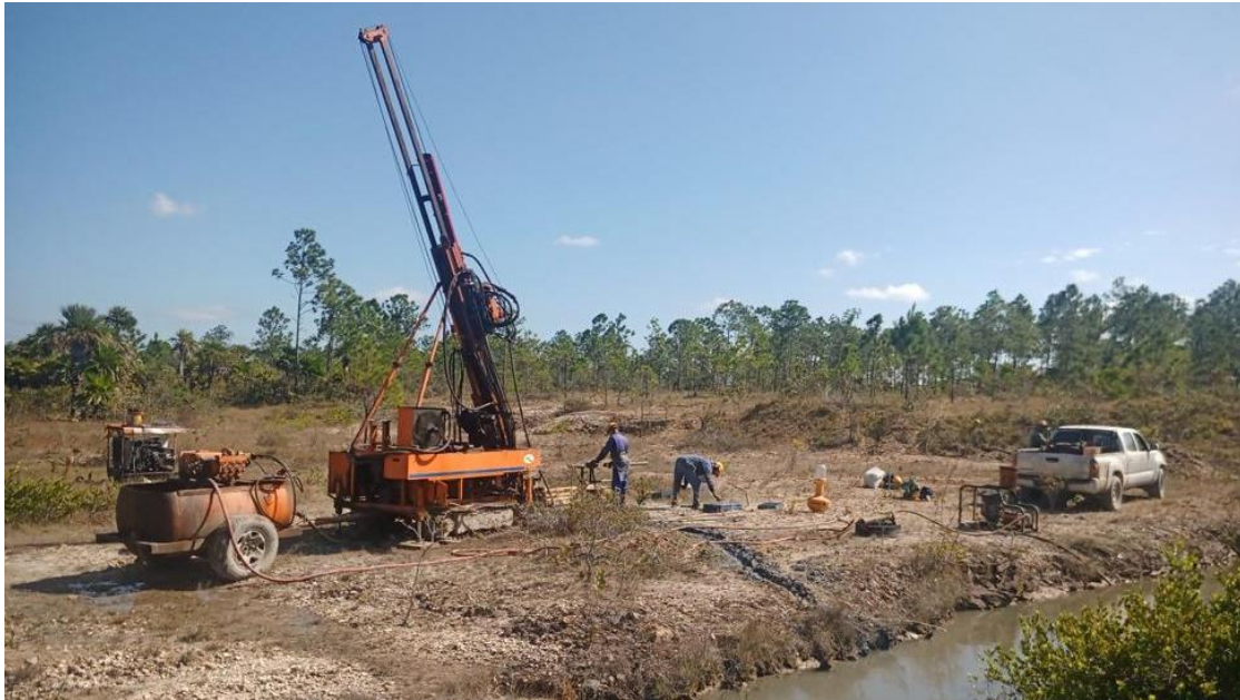
Drilling - El Pilar
