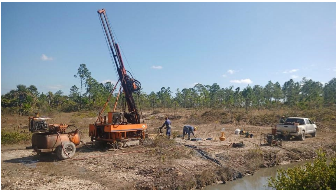
Drilling - El Pilar
