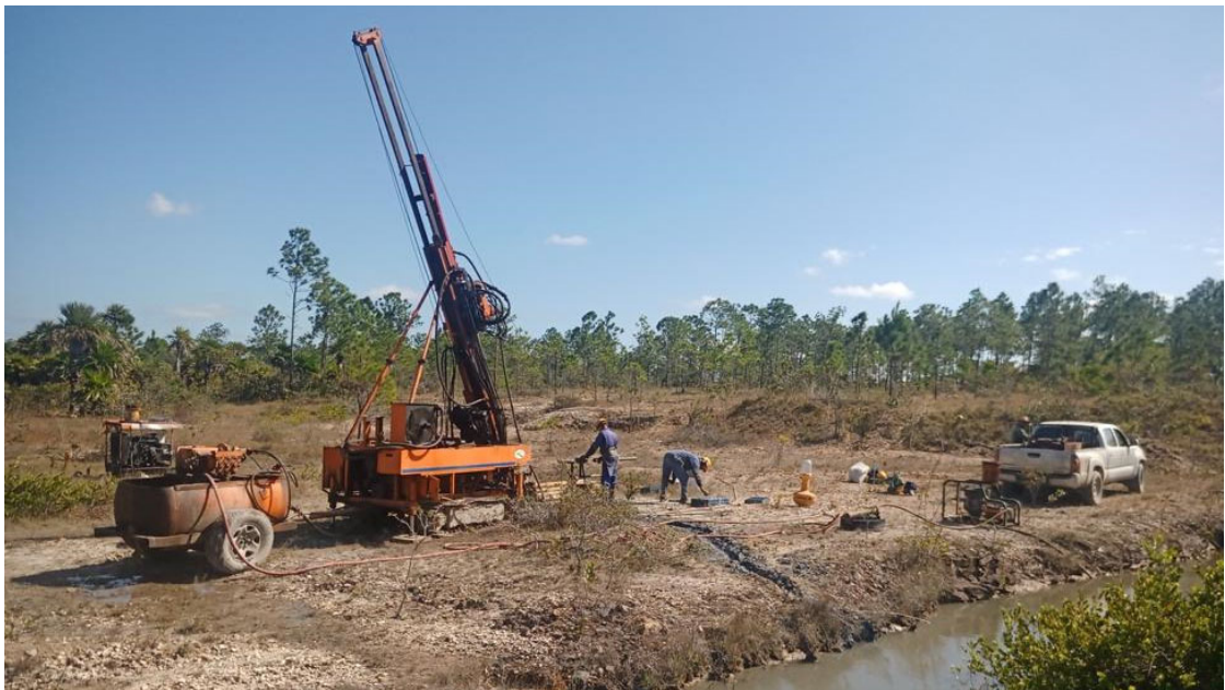
Drilling - El Pilar
