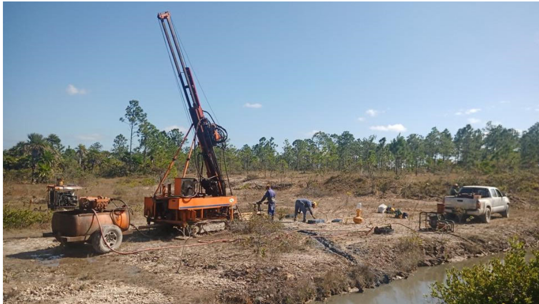
Drilling - El Pilar
