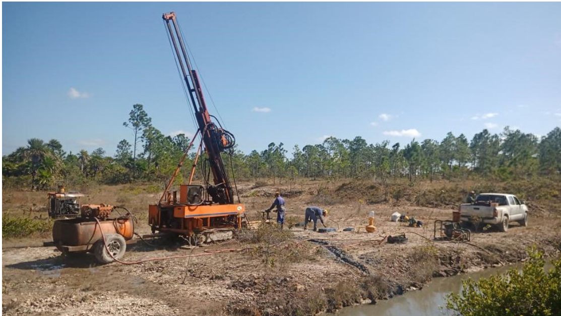
Drilling - El Pilar
