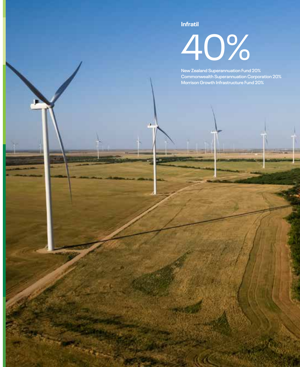
The 243MW El Campo wind farm, Texas
