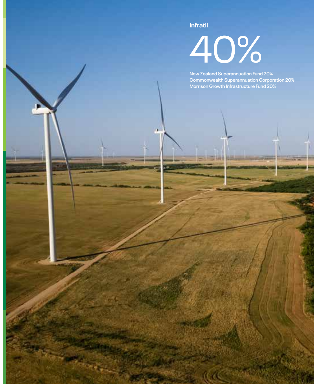
The 243MW El Campo wind farm, Texas
