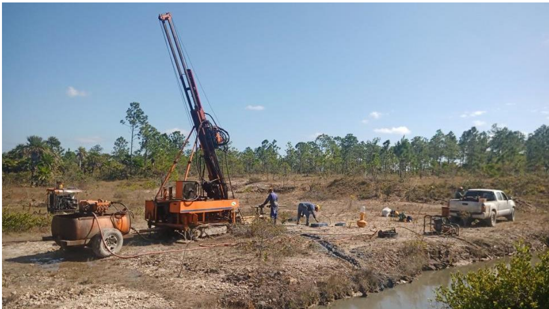
Drilling - El Pilar
