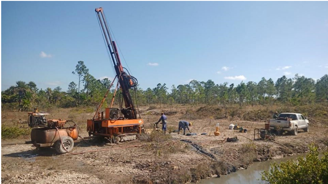
Drilling - El Pilar
