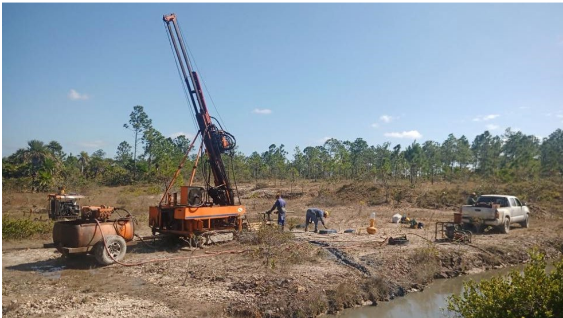
Drilling - El Pilar
