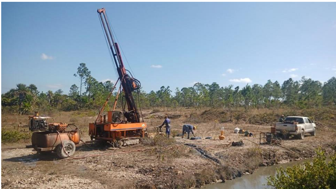
Drilling - El Pilar
