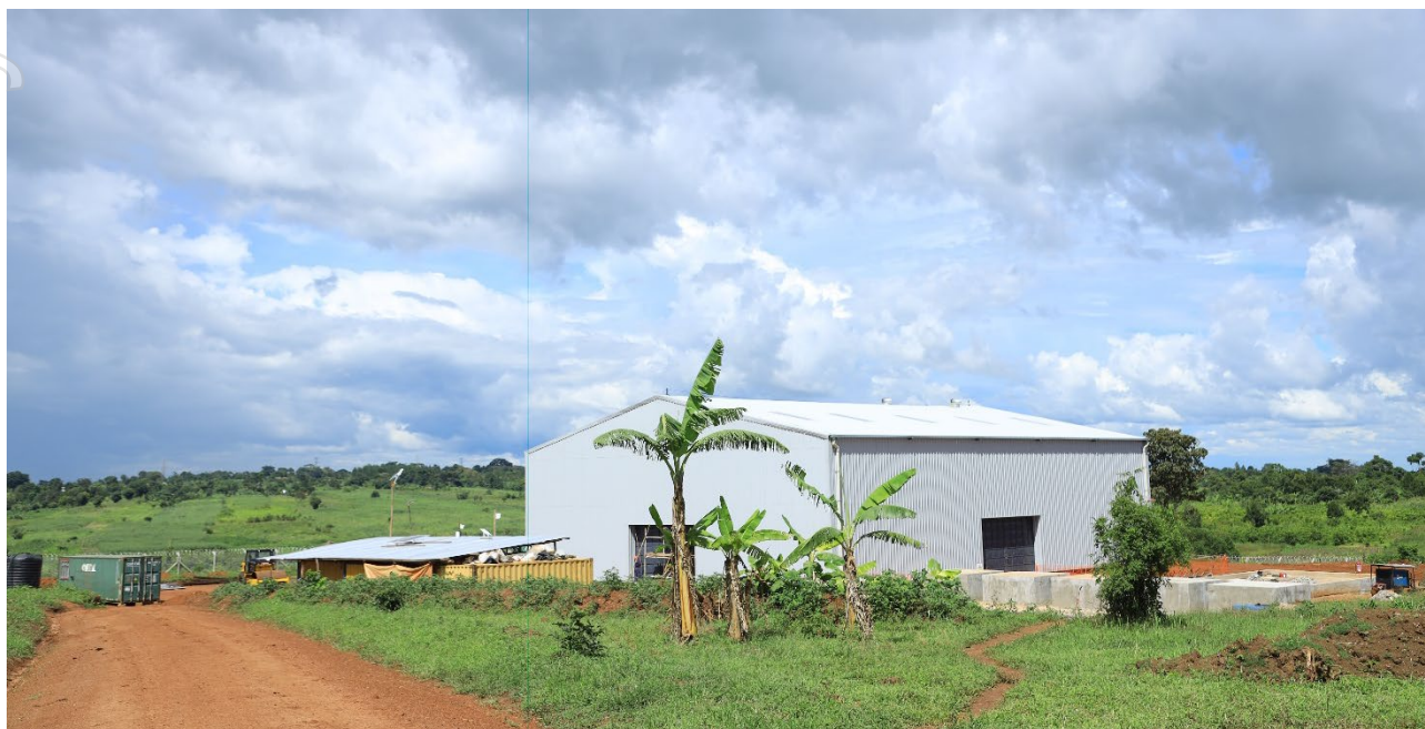
Figure 1: Makuutu Stage 1 Demonstration Plant.
