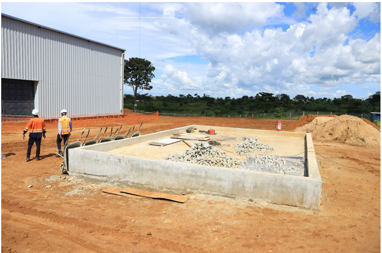
Figure 7: Makuutu stage 1 Demonstration Plant agglomerator pad.
