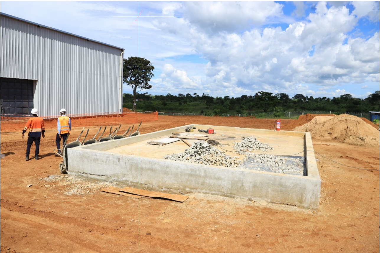
Figure 7: Makuutu stage 1 Demonstration Plant agglomerator pad.
