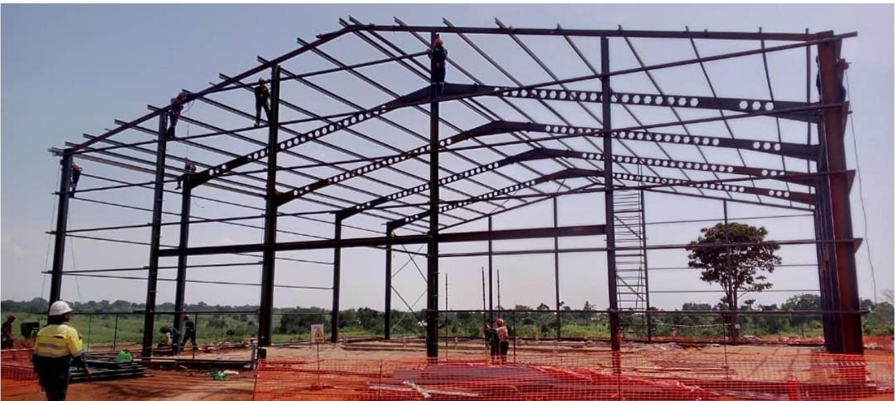
Figure 9: Makuutu Technical Facility frame structure erected.
