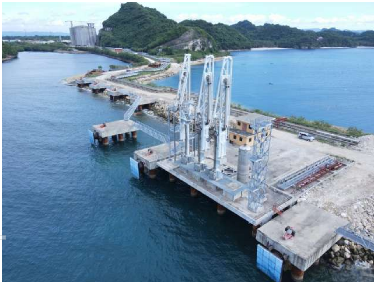
LNG Storage Hub
