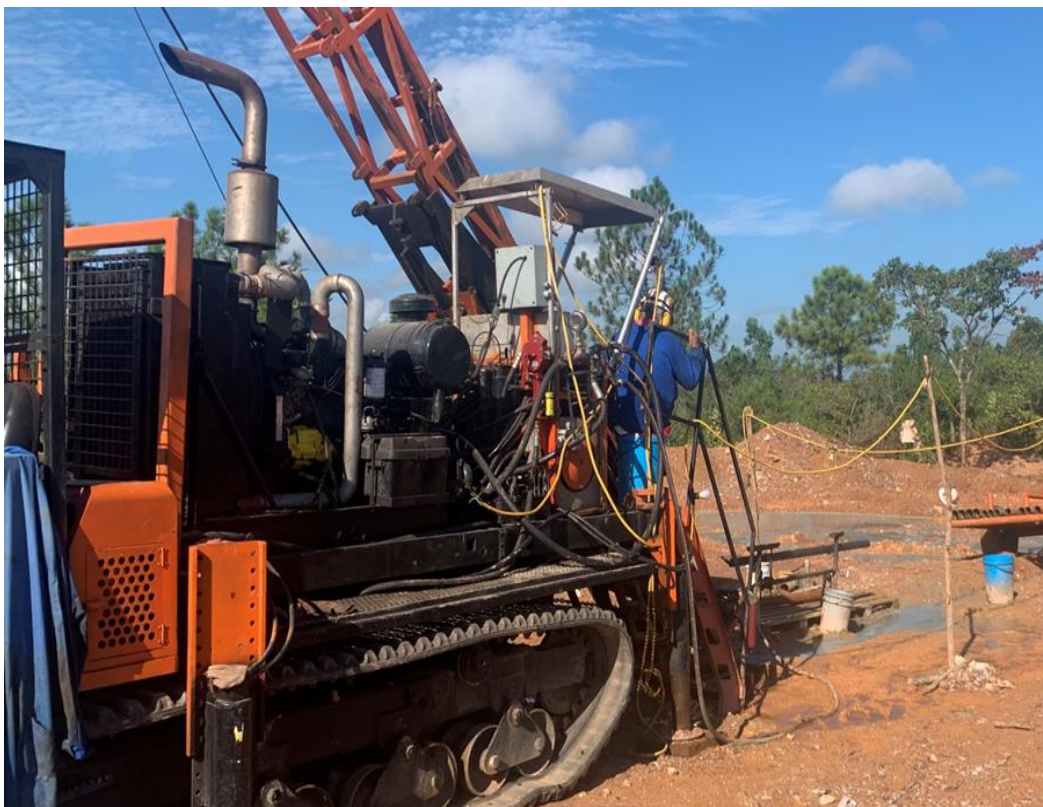
Drilling – El Pilar (September 2022)
