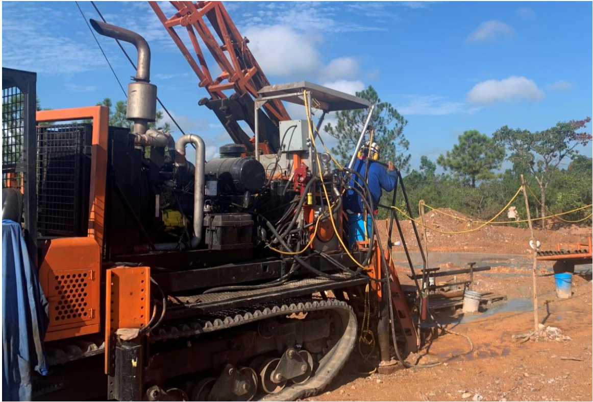
Diamond Drilling – El Pilar
