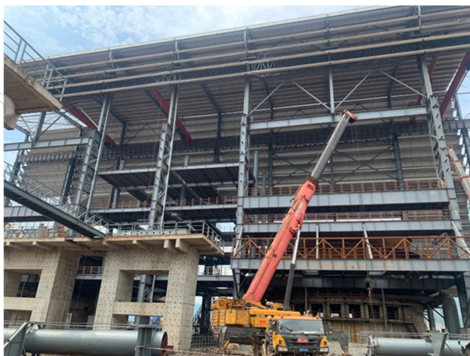
ONI Electric Furnace
