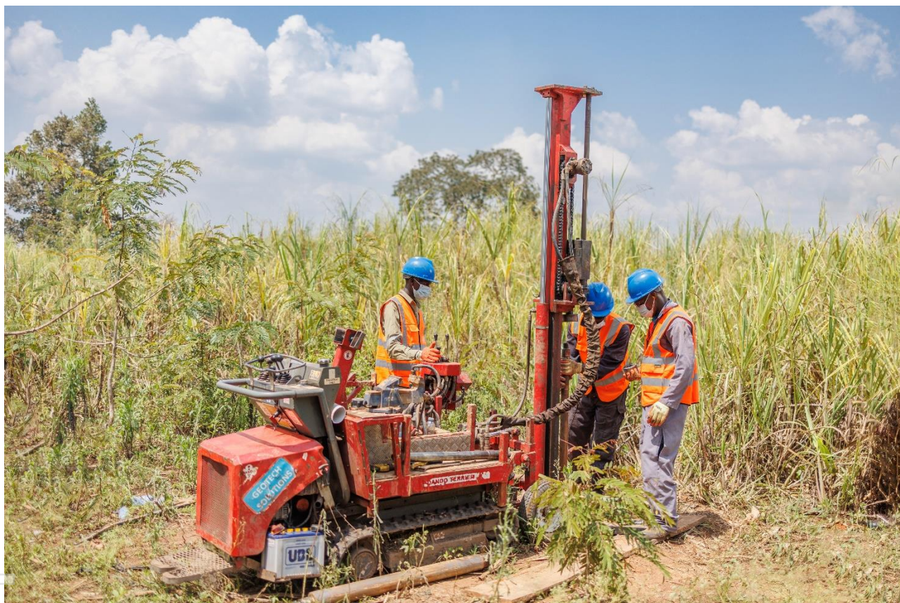
Figure 3: Geotechnical drilling underway at Makuutu.
