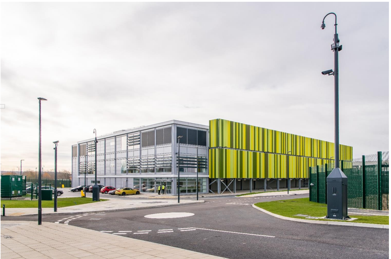
Kao Data's Harlow Campus
