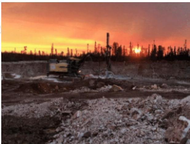
Night shift drilling
